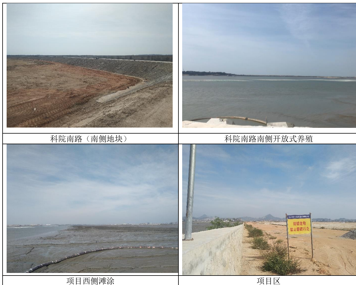
图 5.1-3 项目周边现场照片
