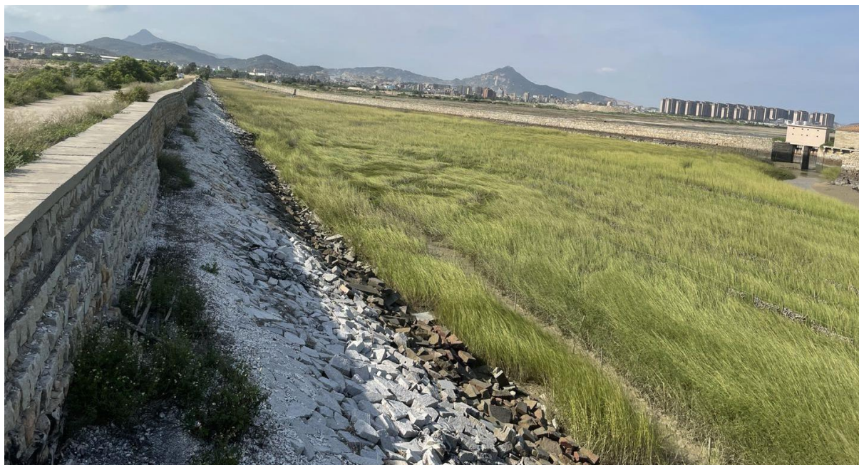
图2.4-3 纵二河护岸乱石放坡
