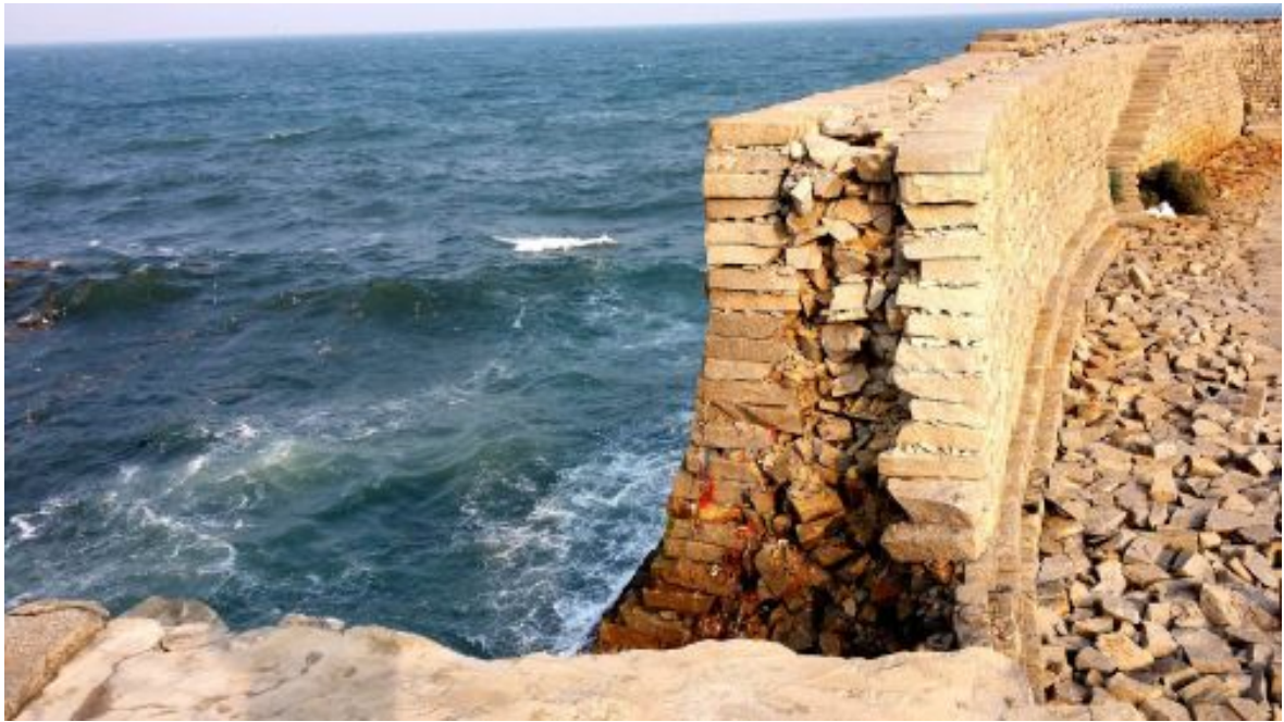
图 2.1-3 东埔历史避风坞北防波堤被天文大潮冲出缺口
