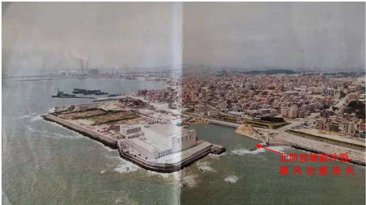
图 2.1-4 东埔历史避风坞受损后（北防波堤被冲毁）
