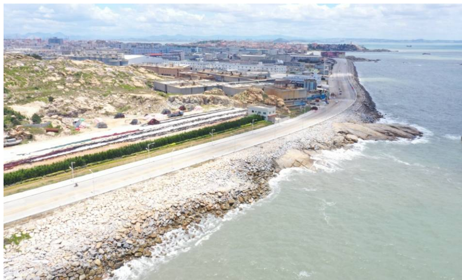
加固防波堤北侧省道201线鸿山段路堤防潮工程
