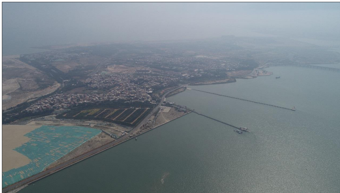
图 5.1-3 大嶝客运码头（自东向西拍摄）
