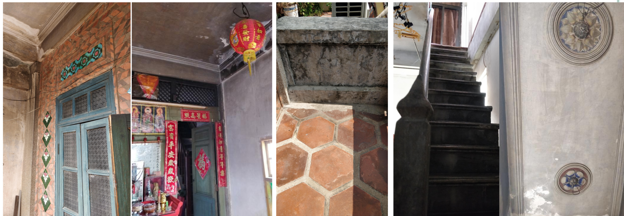
墙面纹样、木门窗 木隔墙/格栅 六角红砖铺装 木楼梯 天花板线脚、纹样
